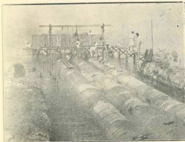
Instalimi i qyngjeve dhe i detyrjeve automatikë në kanalën e Porto Romanos
