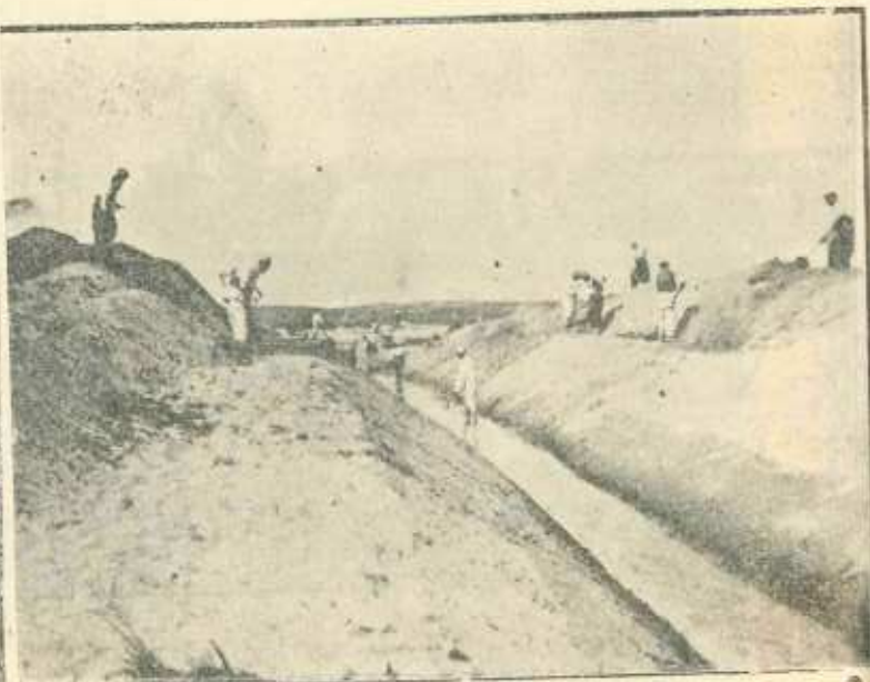
Kanali i daljes prej Shkozës në det
