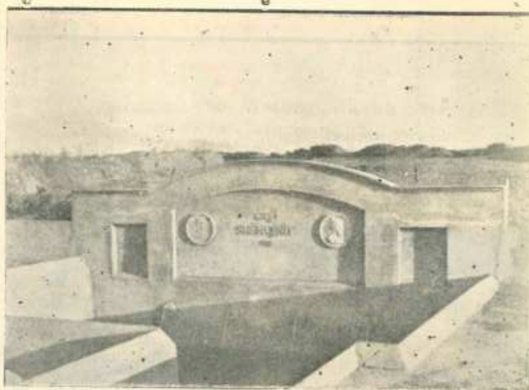
Kroj' i Shëngjinit pas sistemimit
